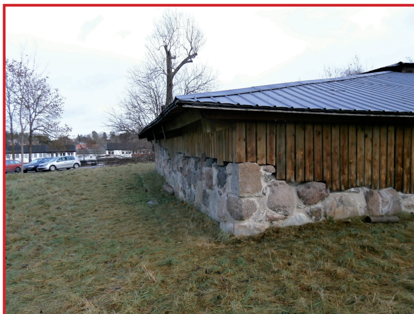
Tuna biskopsborg i Österåker är en ruin med ett påbyggt tak sedan 1960-talet. Detta bör på sikt tas bort och ruinens murkrön konserveras.
